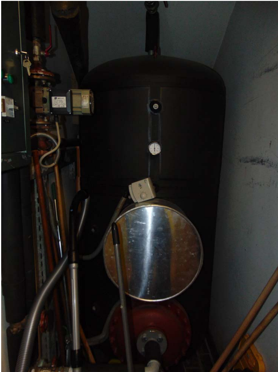
Slika 5 Postojeći spremnik PTV, koji se odpaja sa kotlovnice i spaja na novoprojektirani sustav solarnih kolektora na krovu zgrade
